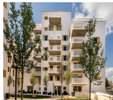
RIVUS VIVERE umfasst 296 Mietwohnungen und komplettiert das Projekt RIVUS in Wien Liesing.
